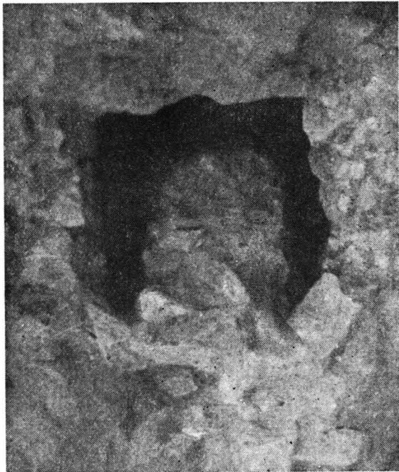
Fig. 22. — Urma unui tirant în zid de nord-est al turnului nr. II.
